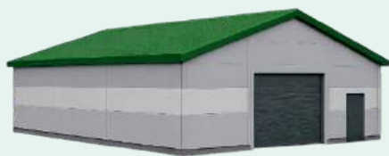
Утепленные (обшивка сэндвич-панелями)
